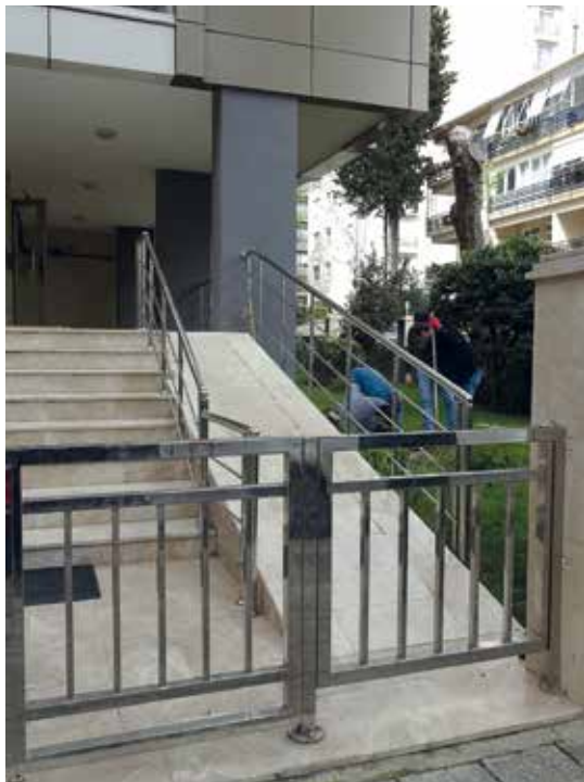
Resim 3. Uygun olmayan eğimde yapılmış rampa (Fotoğraf: Selhan Yalçın Usal, 2019).
