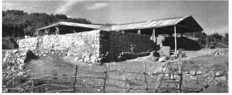
Resim 8. Geçici olarak inşa edilen çatılar ve Kuzey Kapı sur kulelerindeki yeniden yapımlar (Kaynak: ICR Arşivi, 1954, Levha 8'deki panoramik fotoğraf dizisinden uyarlanmıştır).
