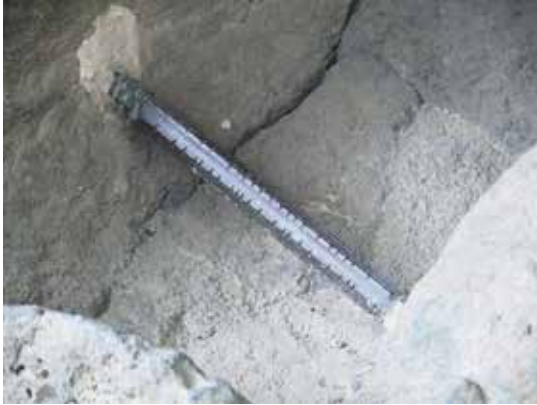
Resim 12. Anastylis uygulamalarında kullanılan piriç çubuk ve yapıstırıcıya bir örnek (Temmuz 2018).
