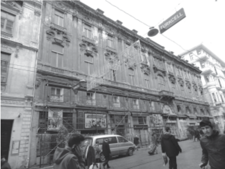
Şekil 4. Cercle d'Orient binasının yıkılmadan kısa süre önceki durumu.
