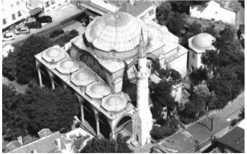
Şekil 4. Rumi Mehmed Paşa Camii hava fotoğrafı (Atatürk Kitaplığı).
