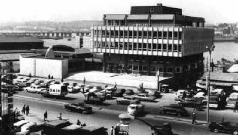
İstanbul Ticaret Odası Binası, kara yönünden görünüş.
