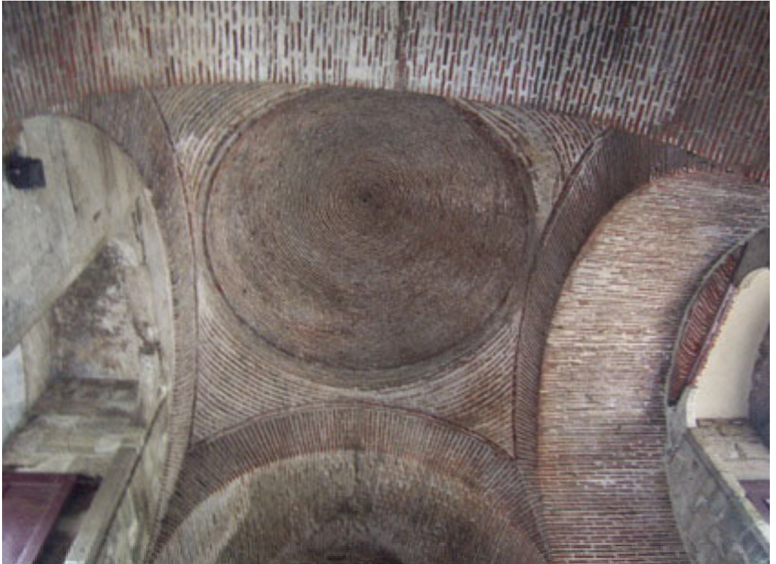
Ayasofya'da ince tuğlanın kullanımı. Yanda, ince tuğla ile örülmüş kubbeler.
