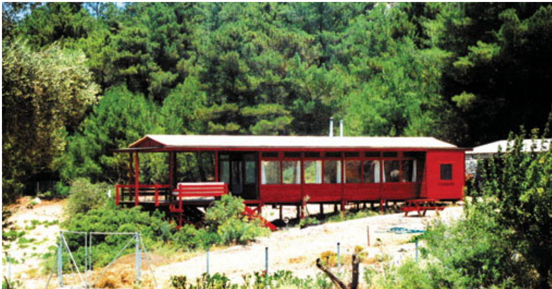
Serhat Akbay’ın Urla, Yağcılar Köyü’ndeki kendi evi. Yapı, Ağa Han Mimarlık Ödülü’ne aday gösterilmişti (Fotoğraf: Serhat Akbay, Yapı dergisi arşivi). Üstte, Akbay’ın evi için hazırladığı bir aksonometrik perspektif çizimi.
