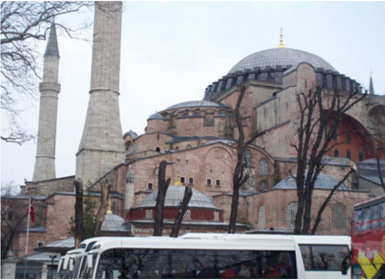
Ayasofya'da ince tuğlanın kullanımı. Yanda, ince tuğla ile örülmüş kubbeler.
