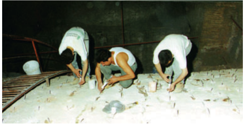
Üstte, basınçsız doğal su kireci enjeksiyonu ile dokular sağlamlaştırılıyor. Yanda ve altta, karbon elyaf takviye çalışmaları
