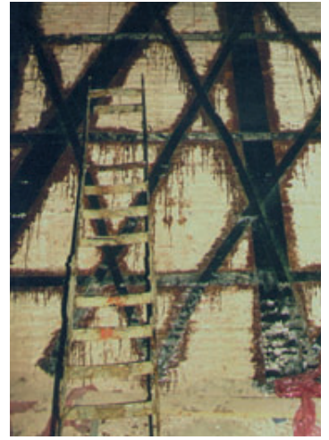
Üstte, basınçsız doğal su kireci enjeksiyonu ile dokular sağlamlaştırılıyor. Yanda ve altta, karbon elyaf takviye çalışmaları
