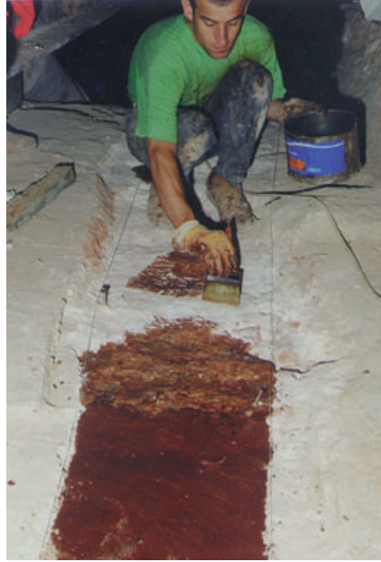
Üstte, basınçsız doğal su kireci enjeksiyonu ile dokular sağlamlaştırılıyor. Yanda ve altta, karbon elyaf takviye çalışmaları
