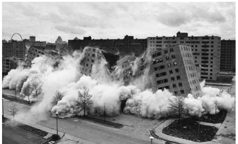
Resim 3. Pruitt-Igoe konutları yıkımı, St. Louis, Missouri, 1972.
