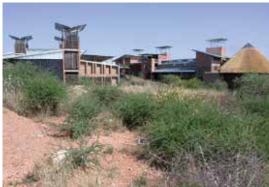
Habitat Araştırma ve Geliştirme Merkezi, Windhoek, Namibya, Nina Maritz.
