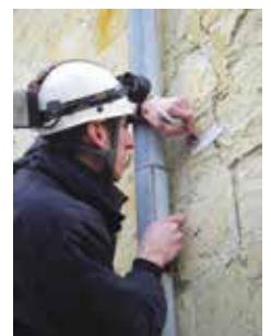
Şekil 3. Tarihi yapılarda inceleme çalışmaları (© Monumentenwacht Vlandereen).
