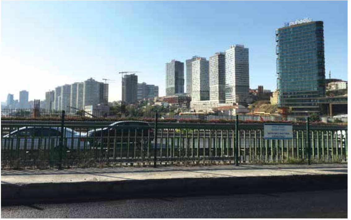
Şekil 2. Fikirtepe'deki yeni yapılaşmalar.
