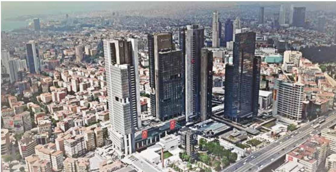
E-5 aksında eski Likör Fabrikası ve Ali Sami Yen Stadı Alanının günümüz görüntüsü ( https://corpneed.com ).
