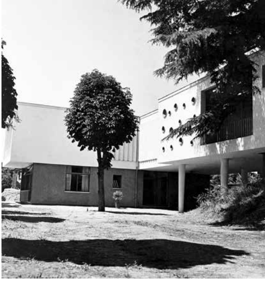
3. Villa Karakurt, Feneryolu, İstanbul, 1956. Mimarlar: Utarit İzgi, Mahmut Bir (Arkitekt ve Utarit İzgi Arşivi).
