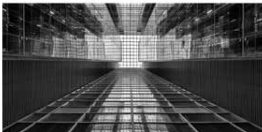
Şekil 6. Yönetim binası, doğal havalandırma ve aydınlatma olanağı sağlayan iç boşluk (Fotoğraf: Cemal Emden).
