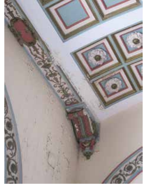
Şekil 1. Yapıların çatı örtüsünde, yağmur oluk ve iniş borularında oluşan kayıp, hasar veya tıkanıklıkların düzenli kontroller yapılarak ortadan kaldırılmaması durumunda yapı cephelerinden uzaklaştırılmayan su, tuz kristallenmeleri, biyolojik bozulmalar gibi yapıya zarar verecek birçok oluşuma neden olmaktadır (a ve b); yapı izlemelerinin yapılmaması durumunda iç mekâna ait dekoratif öğelerin, bezemelerin bozulması (c) ve yapının özgün malzeme ve detaylarının yerinde korunamayacak şekilde zarar görmesi (d) söz konusudur.
