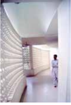
Resim 9. Dış yüzeyi câfî bloklarıyla örülmüş dış koridor, 1998 (Fotoğraf: E. Ardaman).
