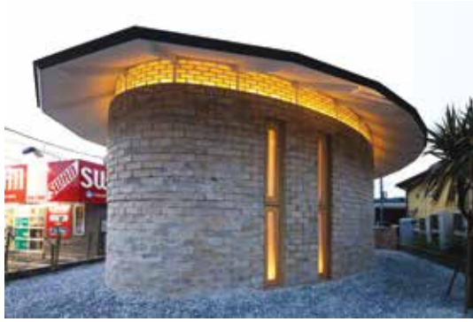
Şekil 8. Sıkıştırılmış toprak tuğla ve yerinde dökme toprak teknikleri ile inşa edilmiş Khamsa Evi, Senegal (URL 4).
