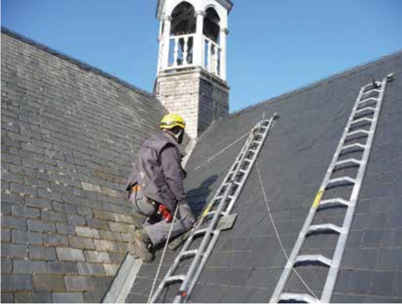
Şekil 2. Çatıda yürütülen inceleme çalışmaları (© Monumentenwacht Vlandereen - Flaman Anıt İzleme Örgütü).
