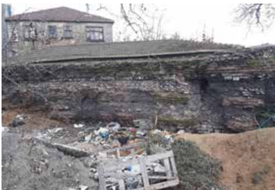
Resim 22. Tribunal'e ait olduğu düşünülen duvarların günümüzdeki görüntüsü.
