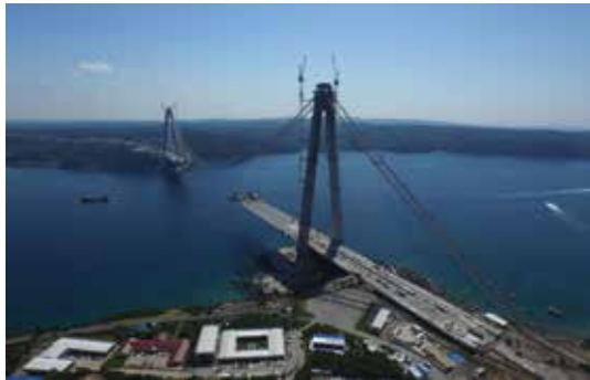
Fotoğraf 6. İstanbul 3. köprü inşaatı (URL 5).
