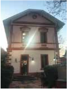
Resim 22. Bakırköy eski gar binası, günümüz (Fotoğraf: Ceyda Güney).
