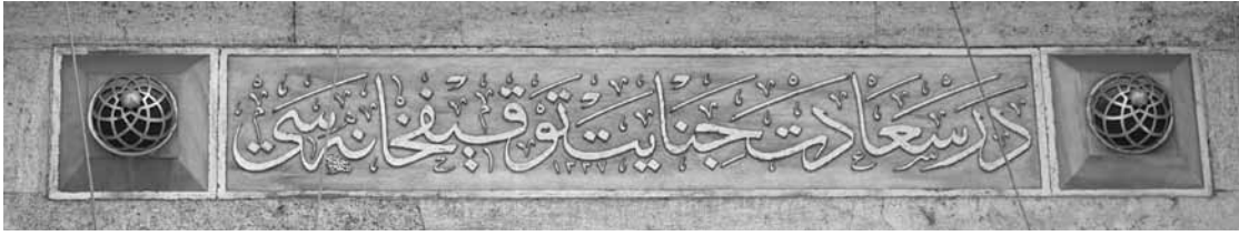
Şekil 9. Sultanahmet Cezaevi girişindeki mermer kitabenin restorasyon sonrası durumu, Haziran 2016: "Dersaadet Cinayet Tevkifhanesi" (Fotoğraf: M. B. Doğan).
