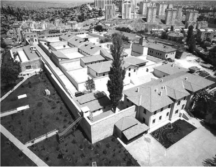
Şekil 5. Ulucanlar Cezaevi, restorasyon sonrası genel görünüm (URL 3).
