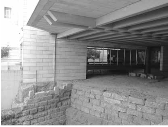
Resim 17. Atina’da çok katlı yapı inşası sırasında ortaya çıkan kalıntıların sergilenmesi.
