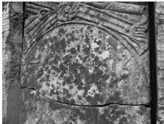
Şekil 12. Anıttaki taş bozulmalarını gösteren ayrıntı.
