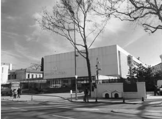
Resim 4. Bulvar tarafından görünüş.
