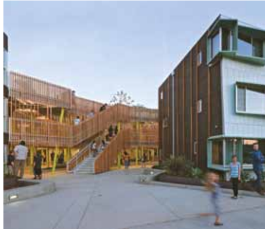
Santa Monica, Kaliforniya, ABD, Tasarım: Daly Genik. Düşük bütçeli konut yerleşmesi. Ucuz görünümlü malzemelerden kaçınılarak, bütçeyi aşmadan yaratıcı ve sade çözümlerle mekânsal ve inşaat kalitesi elde edilmiş.
