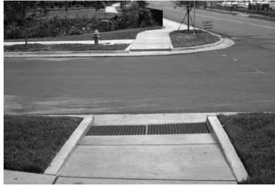
Yaya kaldırımında rampa örneği ( http://charmeck.org/city/charlotte/Transportation/PedBike/PublishingImages/Curb-Ramp-Web.jpg ).
