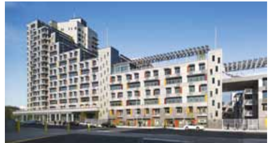
Bergen Avenue’den görünüş: Cephelere hazır panel güneşlik ve balkon monte edildi. Malzemeler arasında tahta, elyaf takviyeli çimento levha ve alüminyum bulunuyor.
