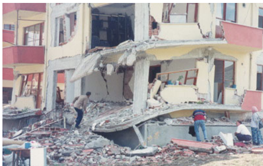
Solda, 12 Ocak 2010 Haiti depreminin, sağda, 17 Ağustos 1999 Marmara depreminin etkileri.
