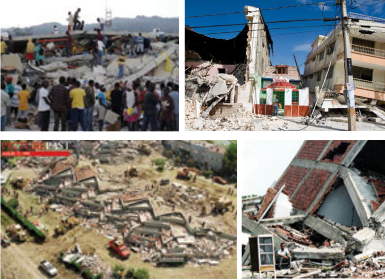
Betonarme yapı bloklarında meydana gelen hasarların benzerliği: 12 Ocak 2010 Haiti Depremi (üstte) ve 17 Ağustos 1999 Marmara Depremi (altta).
