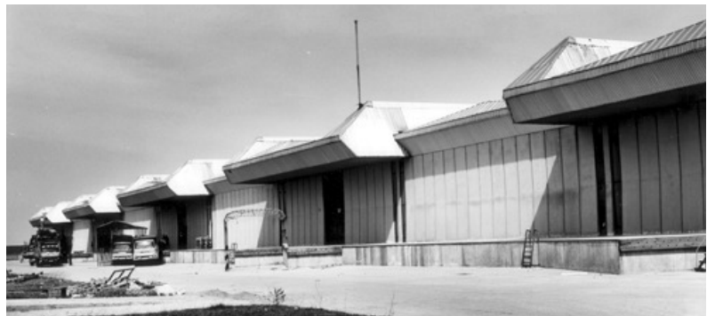
Bekoteknik Fabrikası, Beylikdüzü, 1978.
