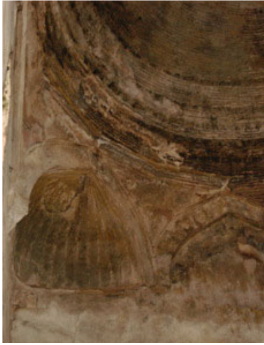
R.17. İznik I. Murat Hamamı'nda istiridye benzeri dilimli tromp.
