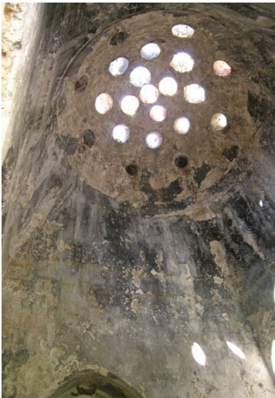
R.3. Yarhisar Orhangazi hamamının geçiş öğeleri yardımıyla iyice yükseltilmiş ılıkliği ve çok sayıda filgözü.
