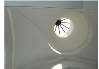
R.8. Bursa Kadı Hamamı sıcaklığında çapraz tonoz taşırmalı basit kubbeli eyvan.
