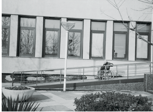
Kadıköy Belediyesi binasına girişte kullanılan bu rampanın eğimi standartlara yakın.
