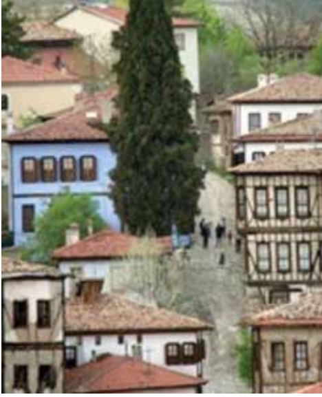
Havuzlu Asmazlar Konağı, Safranbolu
