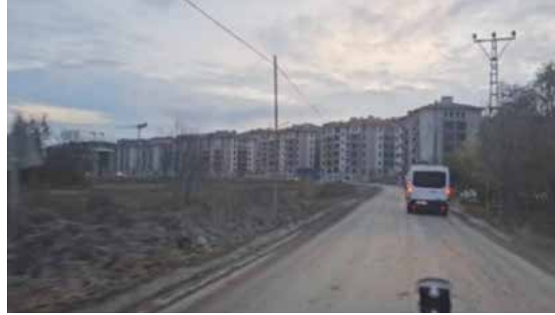
Henüz ÇED Raporu onaylanmayan Kanal İstanbul ve Yenişehir Rezerv Alanı Projesi güzergahında yasa dışı olarak inşa edilen yapılar (Kasım 2024)
