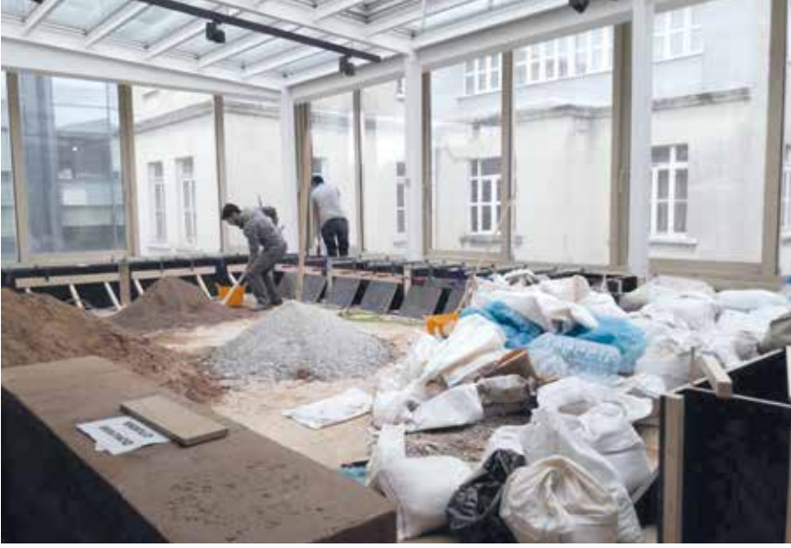
Şekil 11. SALT Kış Bahçesi, yapım aşaması.
