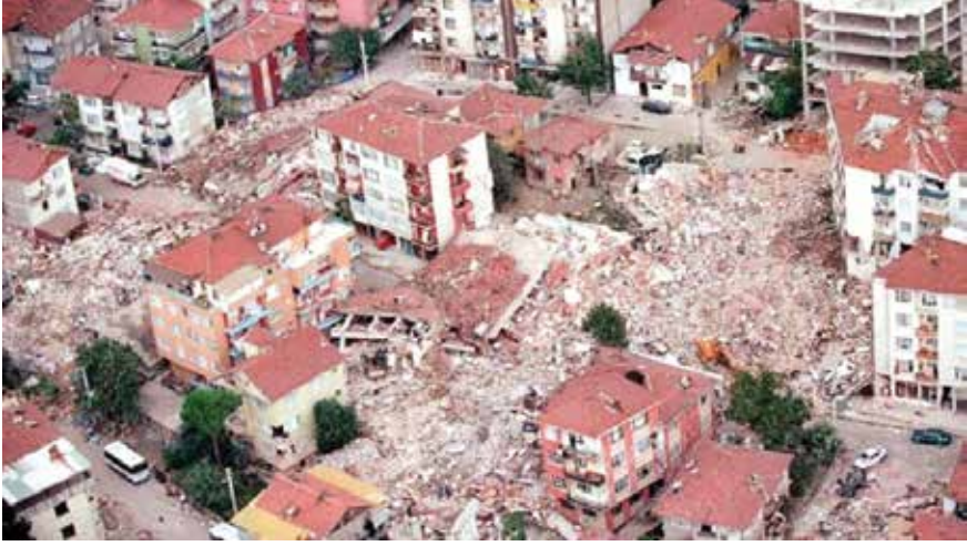
Şekil 9. 1999 Gölçük Depremi (izmir.csb.gov.tr).
